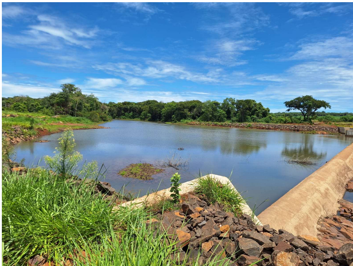
Figura 27 – Vista a partir da ombreira direita eixo da barragem/reservatório
