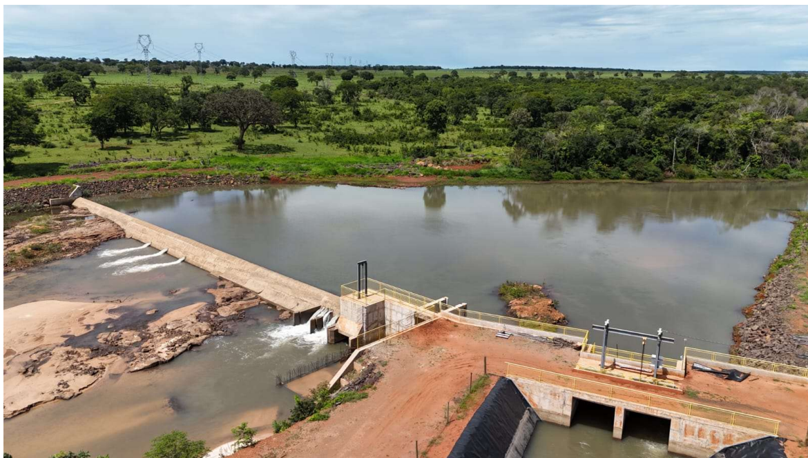
Figura 41 – Vista geral do barramento/estruturas
