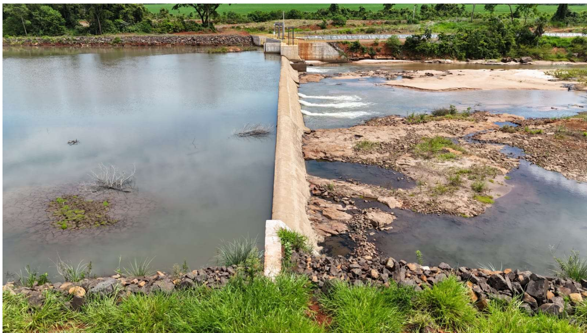
Figura 39 – Vista geral do barramento/estruturas
