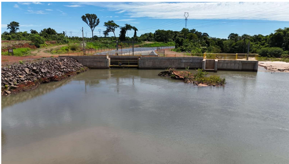
Figura 15 – Vista a montante da tomada d'água, ombreira esquerda e descarga de fundo
