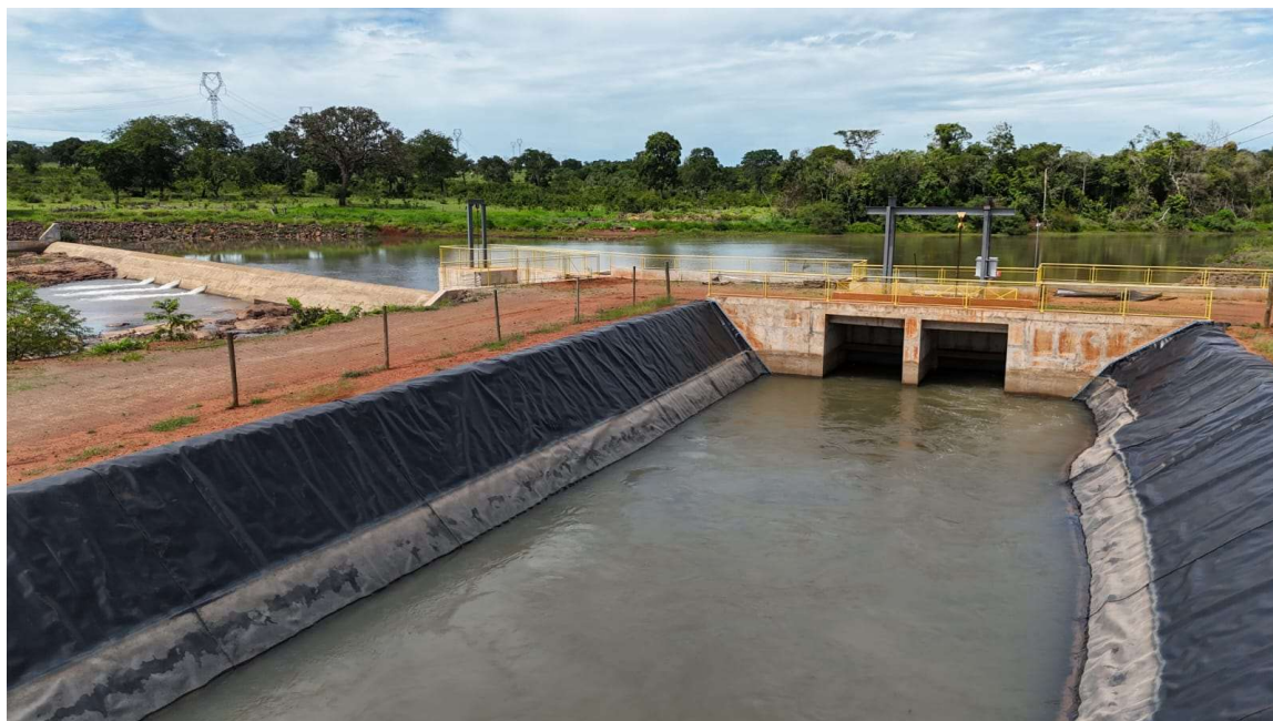
Figura 24 – Vista do início do canal adutor, foco em direção a tomada d'água (jusante)
