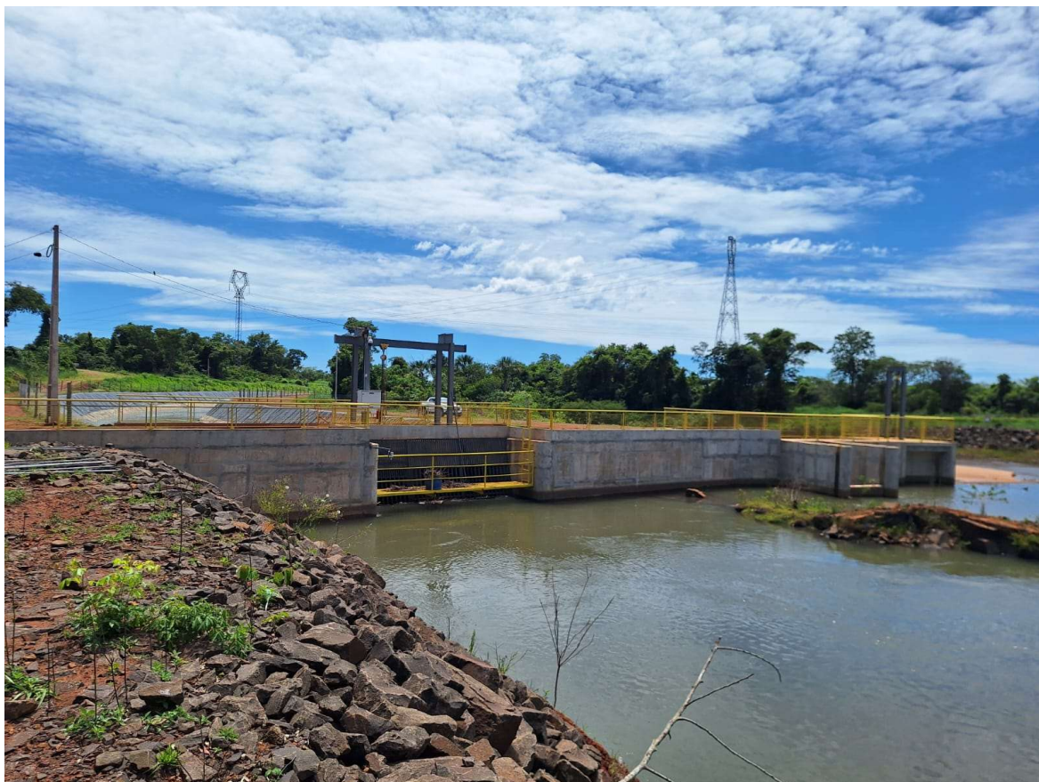
Figura 14 – Vista a partir da margem esquerda, foco em direção tomada d'água/ombreira esquerda
