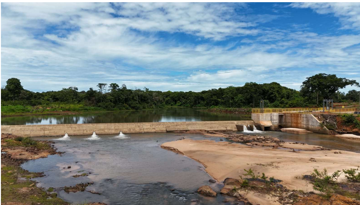
Figura 36 – Vista a partir da jusante da barragem
