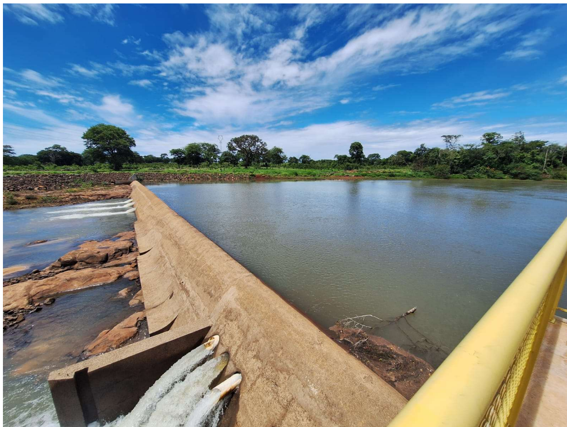
Figura 17 – Vista a partir da ombreira esquerda, foco em direção ao eixo da barragem
