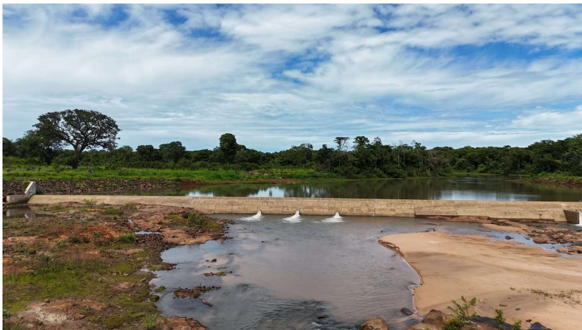
Figura 35 – Vista a partir da jusante da barragem
