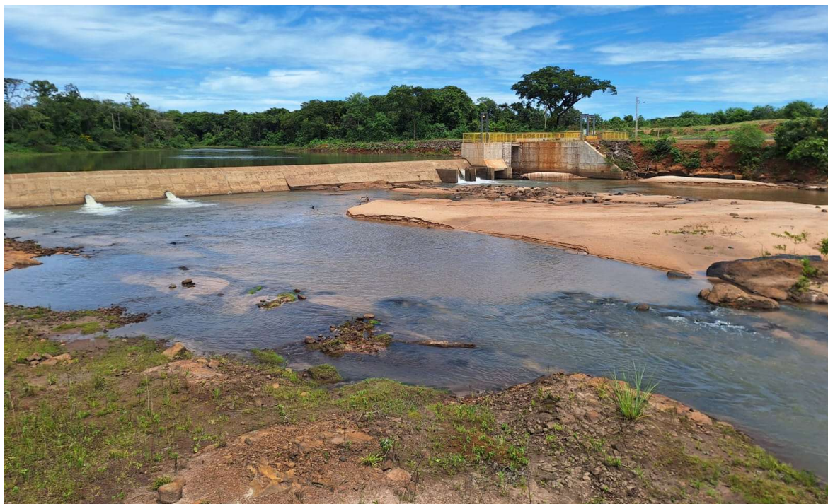
Figura 31 – Vista a partir da jusante da barragem
