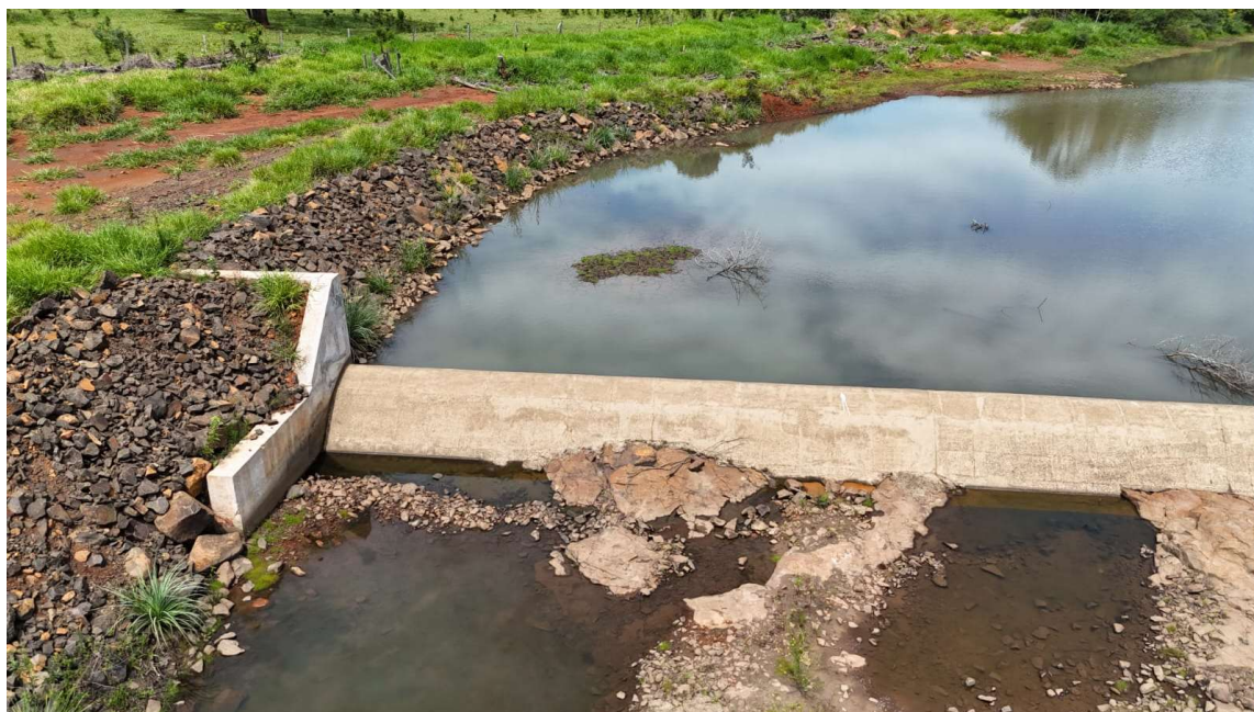
Figura 28 – Vista a jusante da ombreira direita
