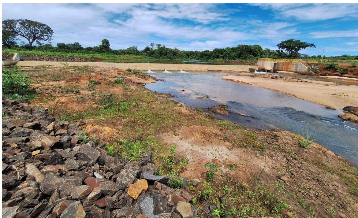
Figura 32 – Vista a partir da jusante da barragem
