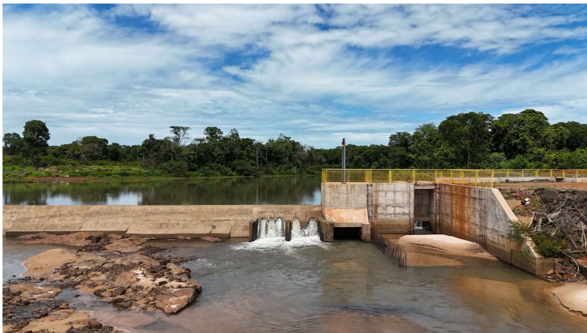
Figura 37 – Vista a partir da jusante da barragem
