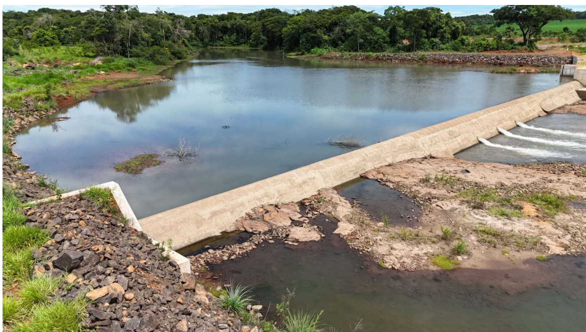
Figura 40 – Vista geral do barramento/estruturas
