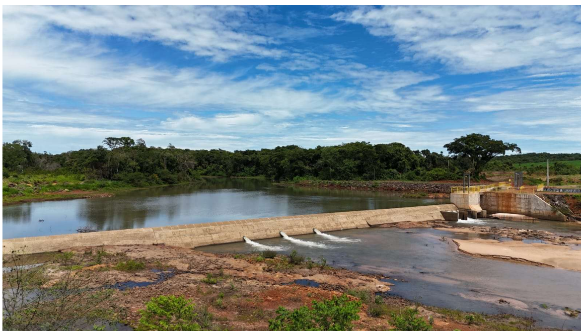
Figura 38 – Vista a partir da jusante da barragem
