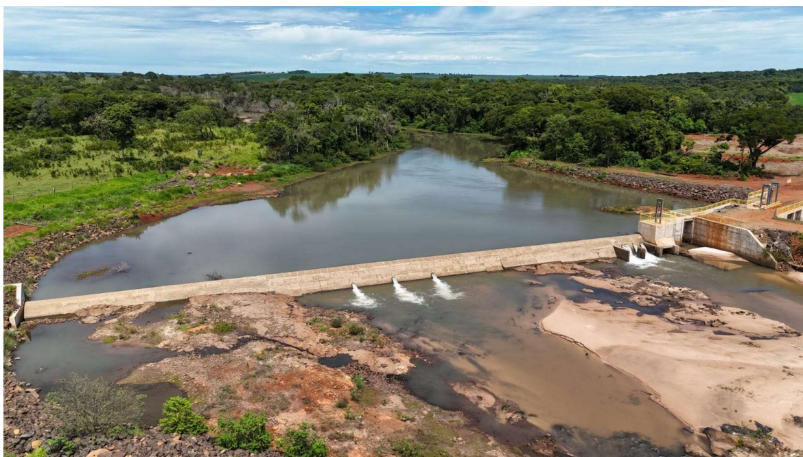
Figura 42 – Vista geral do barramento/estruturas
