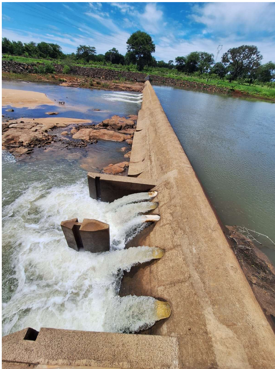
Figura 21 – Vista a partir da ombreira esquerda, foco em direção ao eixo barramento
