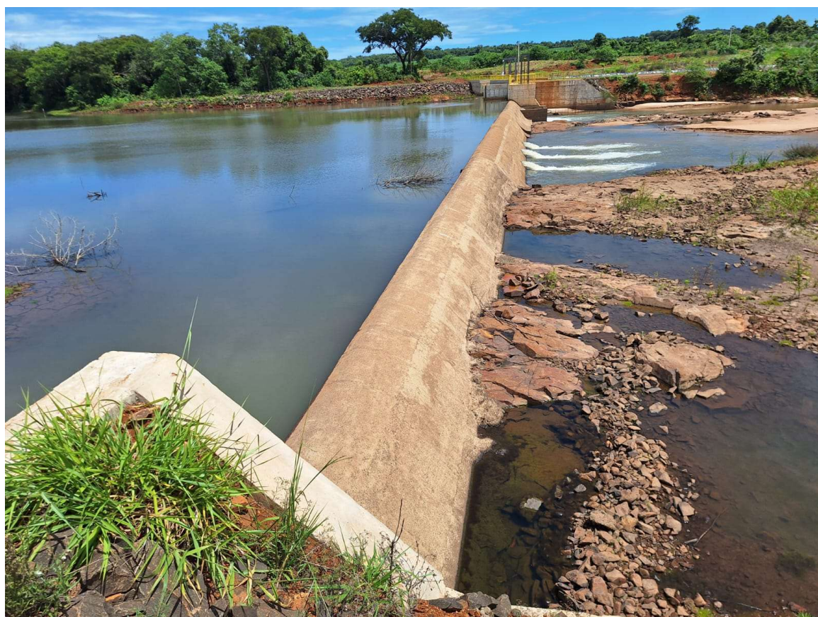
Figura 30 – Vista a partir da ombreira direita eixo da barragem/reservatório
