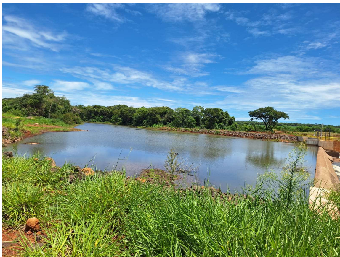
Figura 25 – Vista a partir da ombreira direita (reservatório/eixo da barragem)
