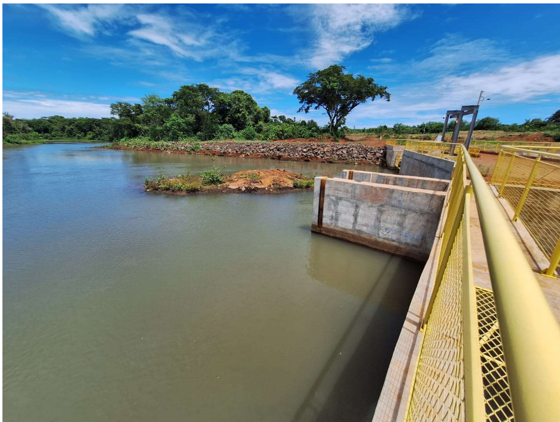
Figura 18 – Vista a partir da ombreira esquerda, foco em direção as estruturas
